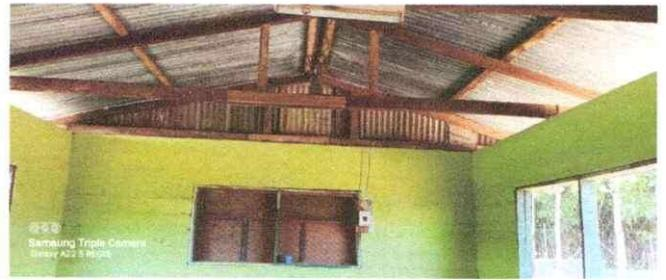
Foto 4: Se observa el soporte de madera en malas condiciones del módulo 2
