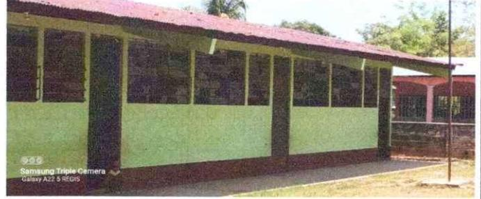
Foto 2: Se observa el desprendimiento de la pintura en puertas y pared. MODULO 1
