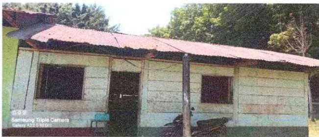
Foto 3: Se observa el deterioro del techo. MODULO 2.
