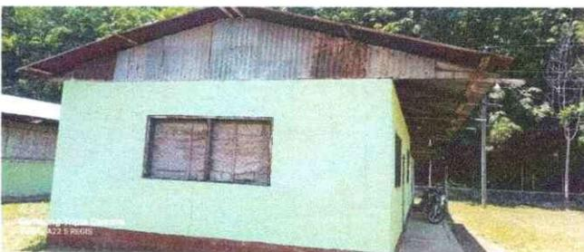
Foto 5: Se observa el desprendimiento de pintura. MODULO 2
